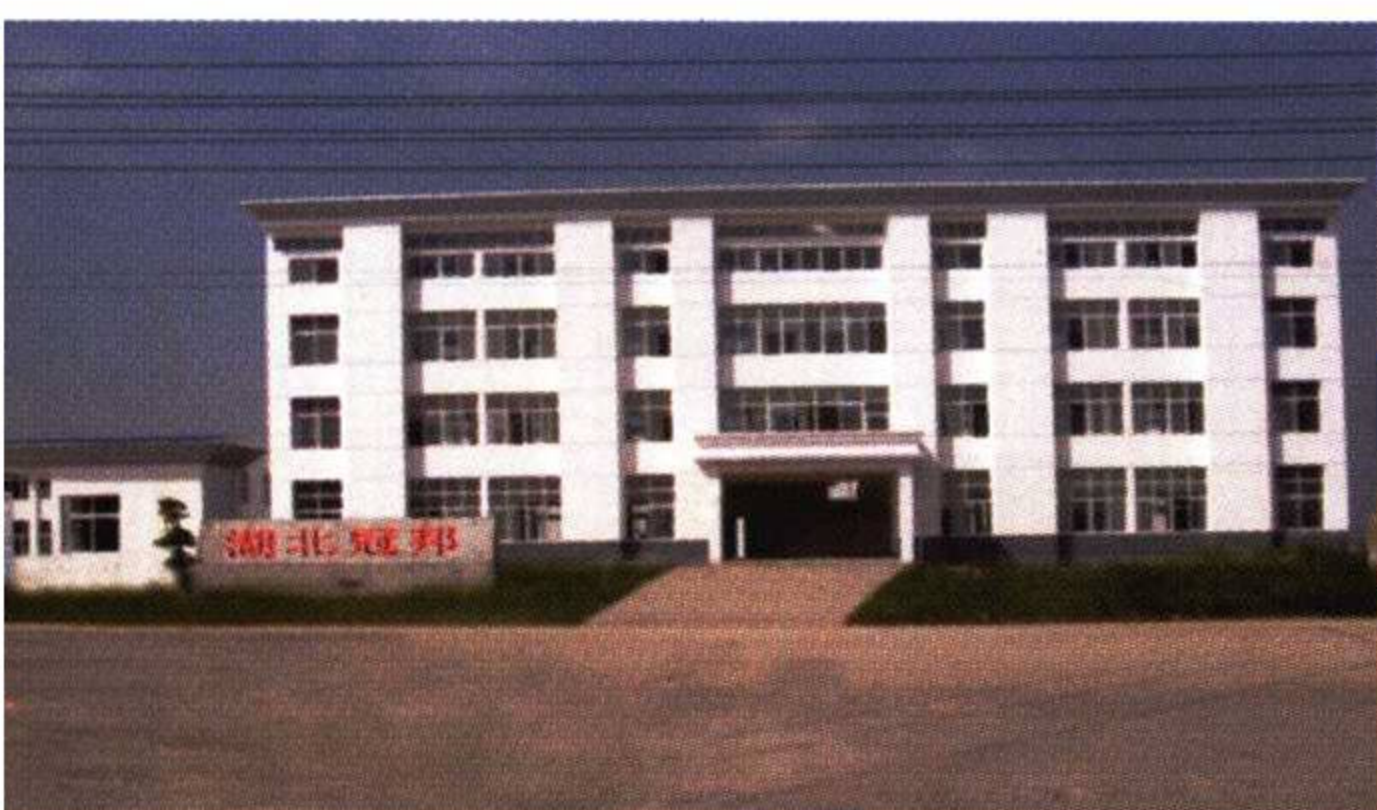
冠邦机械有限公司生产厂房
